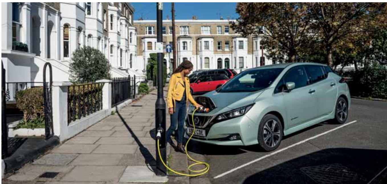
Rys. 2. Przykład stacji ładowania wkomponowanej w słup oświetleniowy
